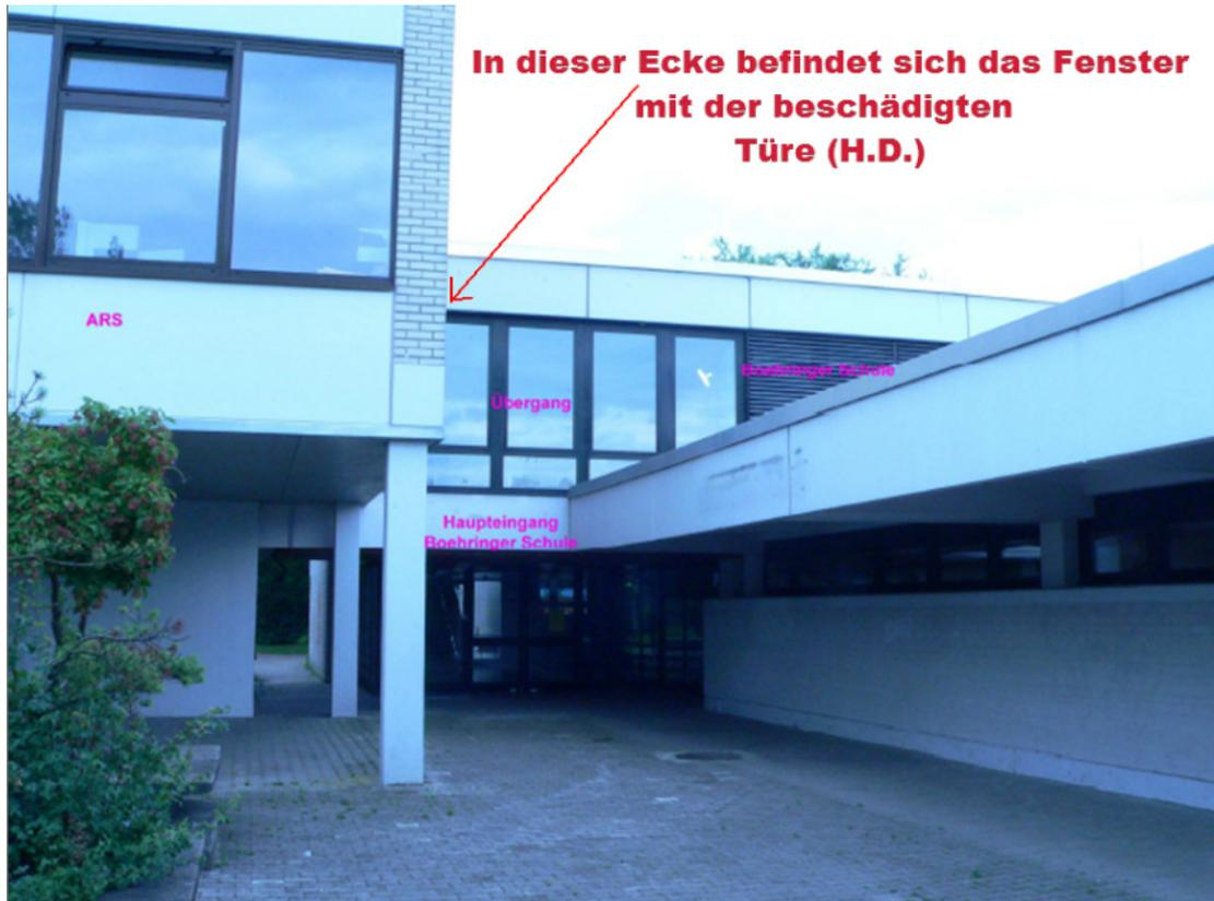
(Text unter dem Bild:) ...Links die ARS. Mittig der Übergang mit der Beschädigung. Rechts die Boehringer Schule. Die dunkle Türe ist der Haupteingang der Boehringer Schule vom Schulhof aus gesehen. Es ist zu sehen, dass die Gebäude physisch komplett entkoppelt sind. Nur durch den Übergang im Mittelegeschoss verbunden.
