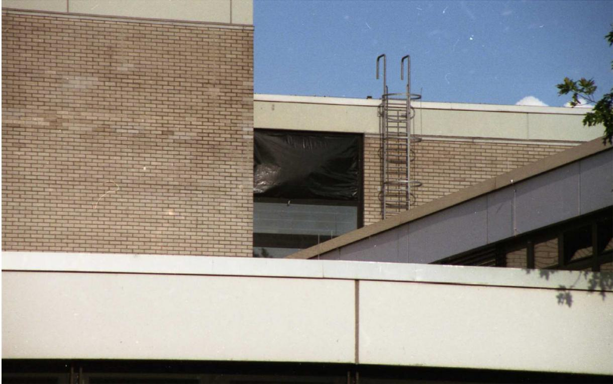
(Text unter dem Bild:)...Man sieht ein Fenster wo das Glas und der komplette Rahmen fehlt und statt dessen durch eine braune Folie ersetzt ist.
