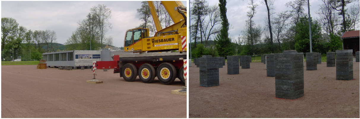
(Linkes Bild hinten: Am 27. 4. stehen schon die ersten Container. Rechtes Bild: der Unterbau)
