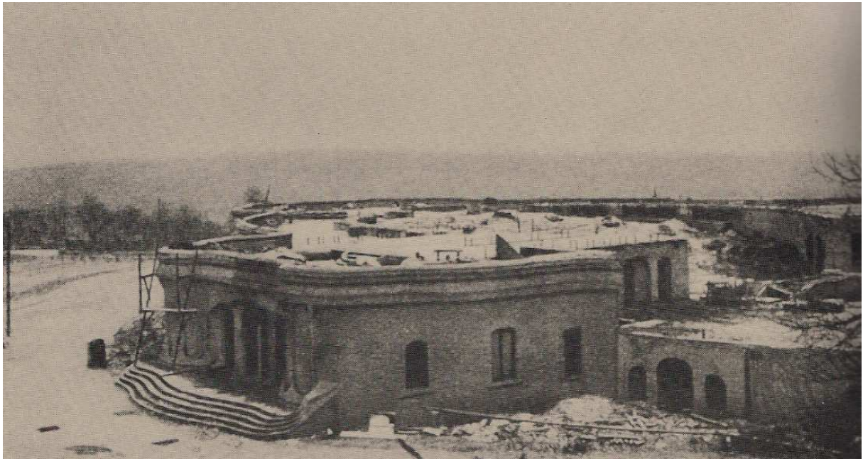
(Nach dem Brand übriggebliebener Betonsockel des Erste Goetheanums , Detailaufnahme)
